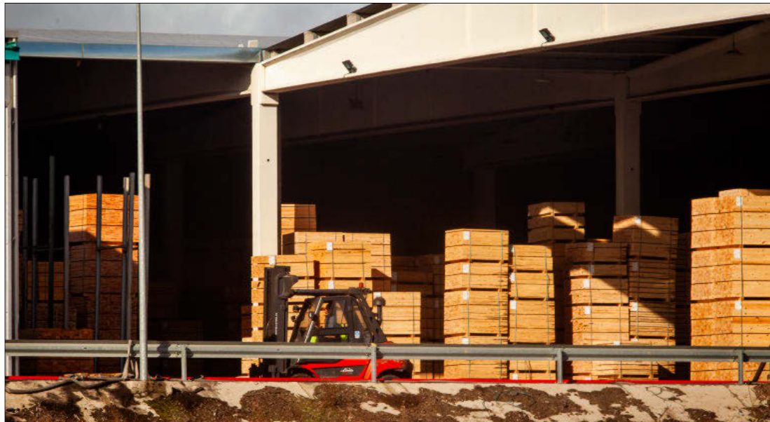
Instalaciones de Tableros Losán en Soria. MARIO TEJEDOR
